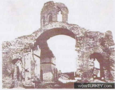
Resim-3: Halebiyye Câmisi'nin yıkılmadan önceki hâl-i pür melâli
