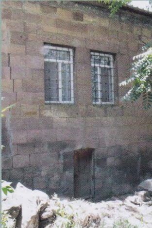
Emanetlerin bulunduğu odanın eski giriş kapısı
