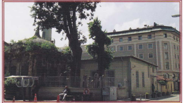
Resim-1: İbni Kemâl Hazretleri'nin dedesi Kemâl Paşa'nın âzatlısı Ahmet Bey'in yaptırıp efendisine ithâfen Kemâl Paşa Câmii diye adlandırdığı câmii
