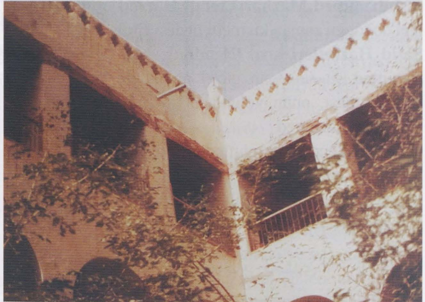
Resim 10: Muhammed Mazhar Efendi Hazretleri'nin 1293 (1876) tarihinde Medîne'de inşa ettirdiği Mazharî Ribât'ın iç tarafı
