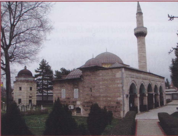
Resim 3: Üsküp İshak Paşa Câmii (yıkılan medreseden bir eser kalmamıştır)
