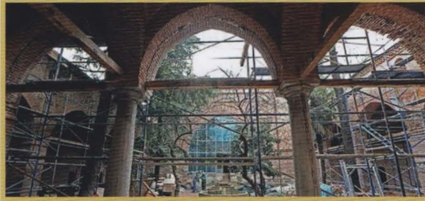
Resim-2: Şu anda tâmirâtı devâm eden 2.Murâd Hân'ın Murâdiye Külliyesi içerisindeki medresesi
