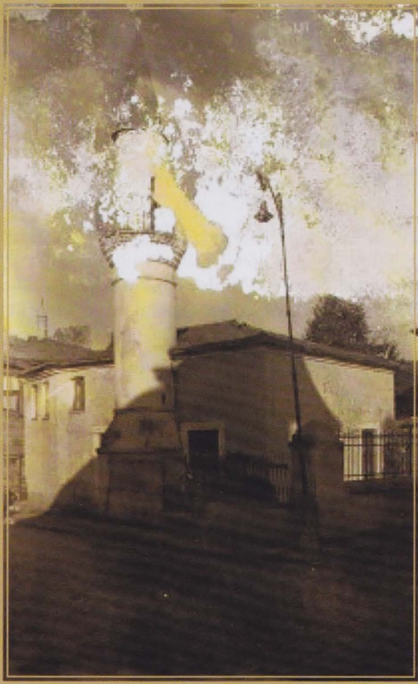
Resim-1: 1957'deki yol yapımında yıkılan Voynuk Şücâeddîn Câmii'nin 1940 yılındaki fotoğrafı
