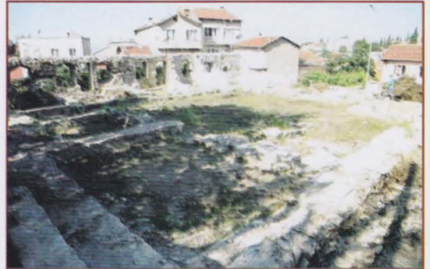
Resim 1: Bursa Bayezid Paşa Medresesi'nin yenilenmeden önceki son durumu
